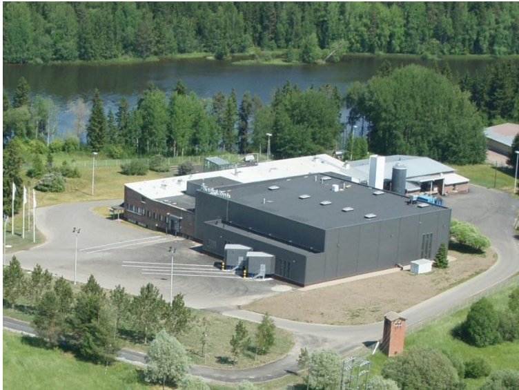
Kaslink Foods Oy:n kotipaikka sijaitsee Koriolla, Kouvolassa. Tehdaslaajennus valmistui maaliskuussa 2011.
