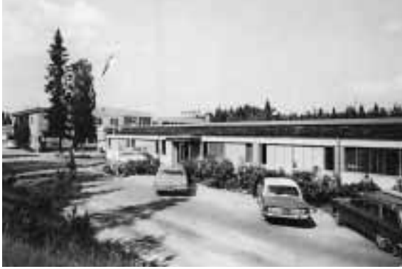
Pikval Oy:n Keltinmäen tehdas Vaajakoskella valmistaa mm. myymäläkalusteita.
