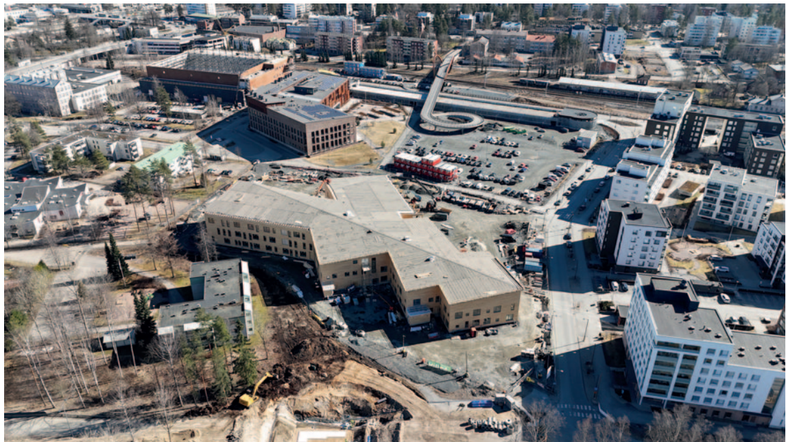
Etualalla on rakenteilla oleva Hangonsillan alueen koulu- ja päiväkotikokonaisuus Vilinä. Kuvan vasemmassa yläkulmassa näkyy rakenteilla oleva Hyvinkää Areena. Näiden rakennusten välissä on Hyvinkään Kipinä-lukio.
