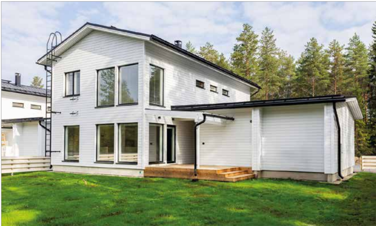
Puutuomelan rakentama moderni omakotitalo sulautuu luontevasti ympäröivään maisemaan.
