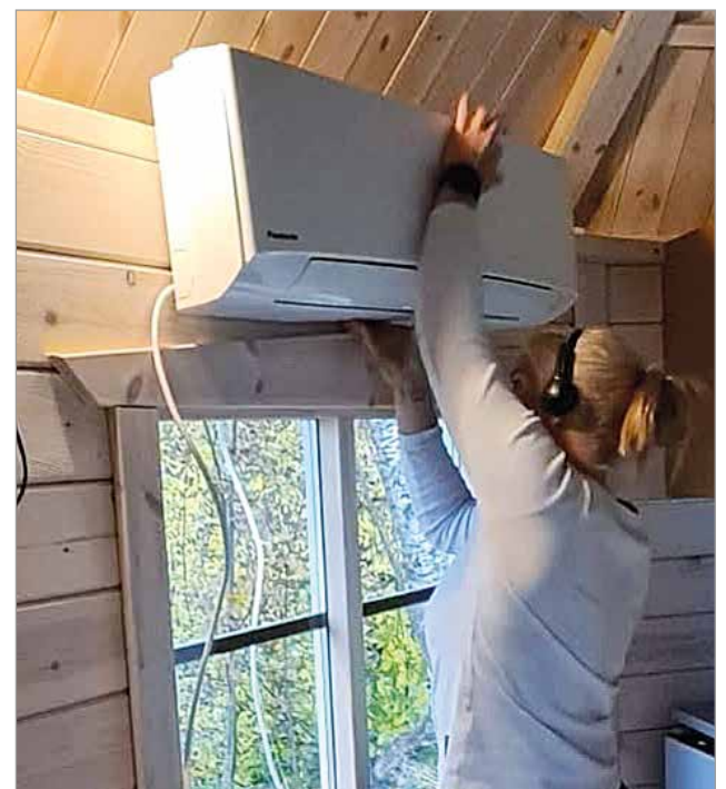
Ilmalämpöpumpun asennus on järkevintä hoitaa hyvissä ajoin.
