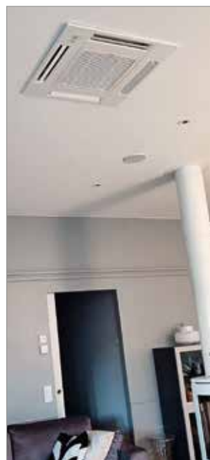
Integroitu kattomallinen ilmalämpöpumppu on saatavilla saneeraus- ja uudiskohteisiin.
