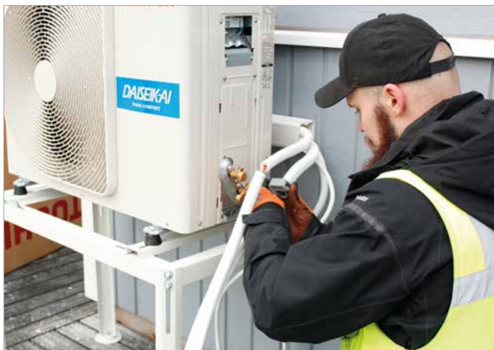
CoolerYkkösten asentaja ilmalämpöpumpun asennushommissa.
