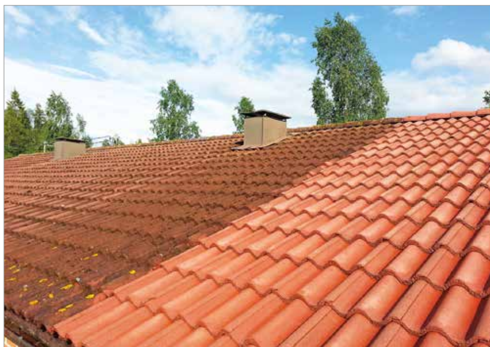
Puhdistettu ja pinnoitettu katto on kuin uusi, kuten kuvasta näkyy. Vasemmalla ennen ja oikealla jälkeen.
