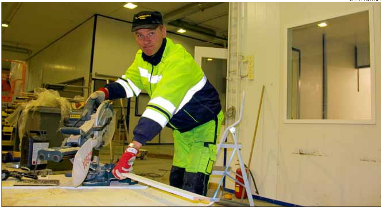
Ojalan hallista näkyy jälleen valot. Remonttitöitä hallissa tekemässä Esko Kaski kuluva vuoden alussa. Tilamuutosten jälkeen Aimo Ojalan omistamassa ja Flexin lähdön jälkeen tyhjiilleen jääneessä hallissa on alkanut toimia monta eri alan yritystä.
