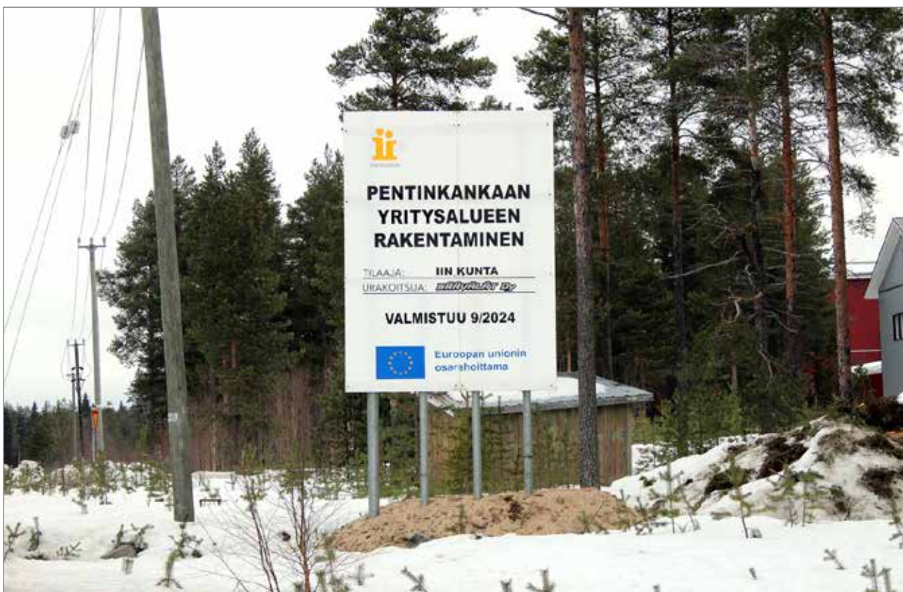
Pentinkankaan yritysalueen rakentaminen on käynnistynyt.
