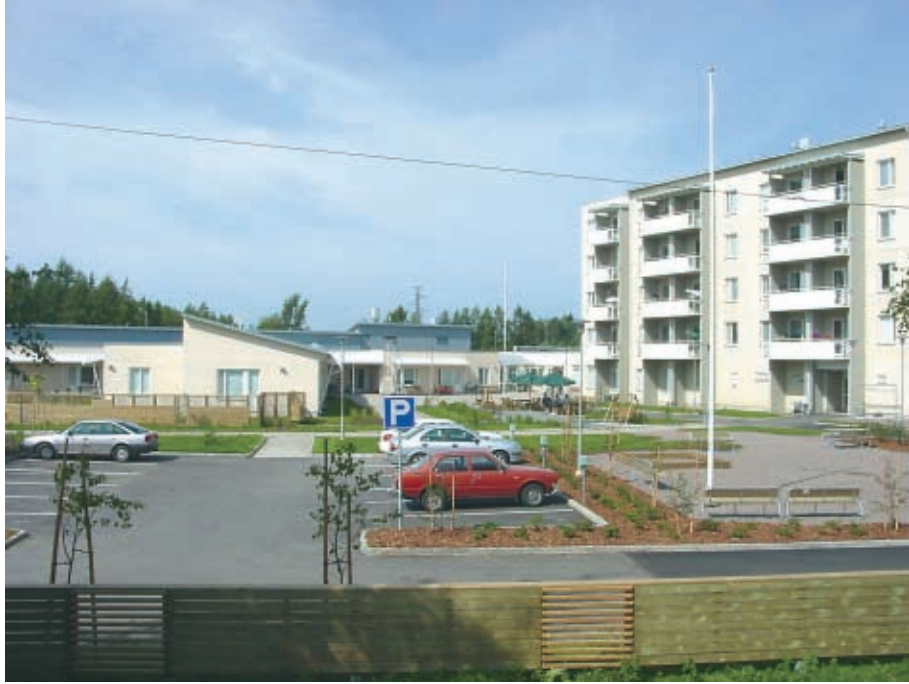
Kuva 10. Kotipirtin Palvelutalo Tampereella, vasemmalla yksikerroksinen ryhmäasunto Tyynelä, keskellä yksikerroksinen palveluosa ja oikealla viisikerroksinen palveluasuntorakennus Onnela.
