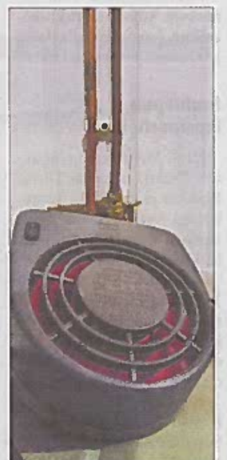
Jäätynyt putken sulattaminen on hidasta ja varovaista hommaa.
