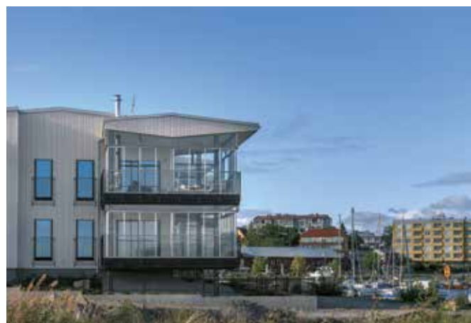
Två av de tio våningshus som Jan-Erik och Elina ska bygga på Drottningberg i Östra hamnen står i nuläget klara.
